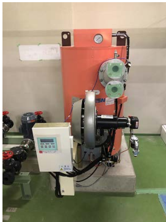
温水ボイラ納入(R2. 11. 4)
