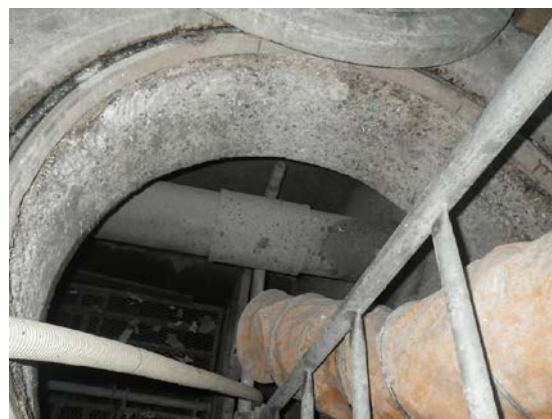
防食塗膜工事②(R2. 7. 13～)
