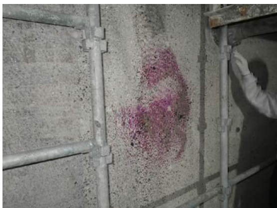
防食塗膜工事除去後検査①(R2. 7. 28)
