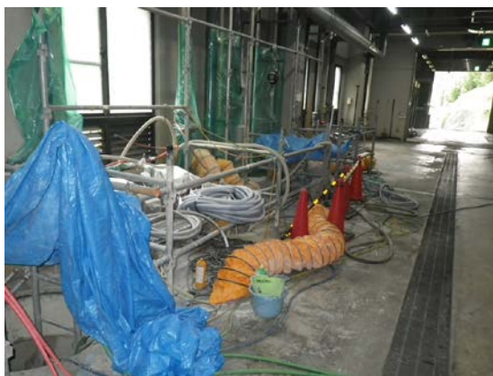
防食塗膜工事①(R2. 7. 13～)
