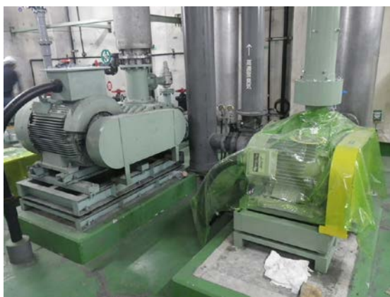
流動床ブロワ設置(R2. 7. 8)
