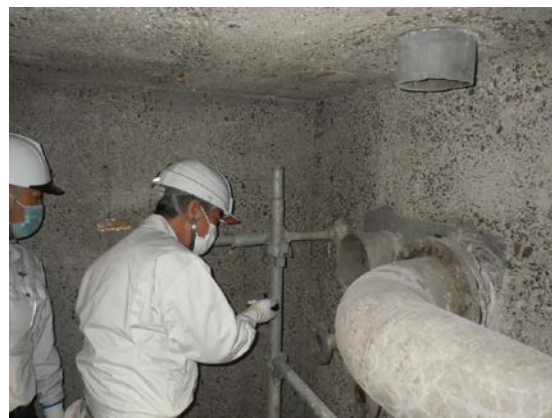
防食塗膜工事除去後検査②(R2. 7. 28)
