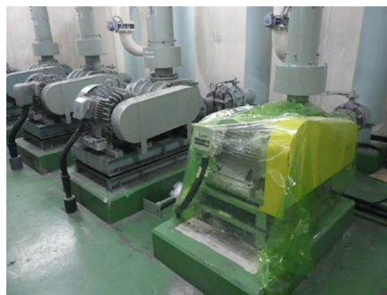
貯留槽ブロワ設置(R2. 7. 8)
