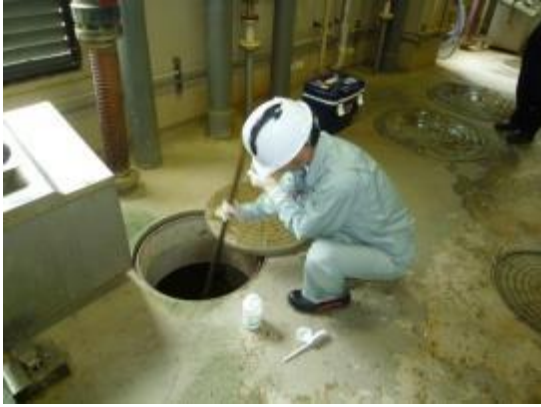
試料採取 作業(1) 浄化槽汚泥 採取
