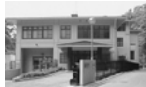
平成13年竣工 現在の大谷処理場
