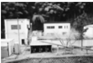
昭和46年 竣工当時の大谷処理場
