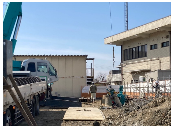
基礎杭除去(R8. 3. 17～)
