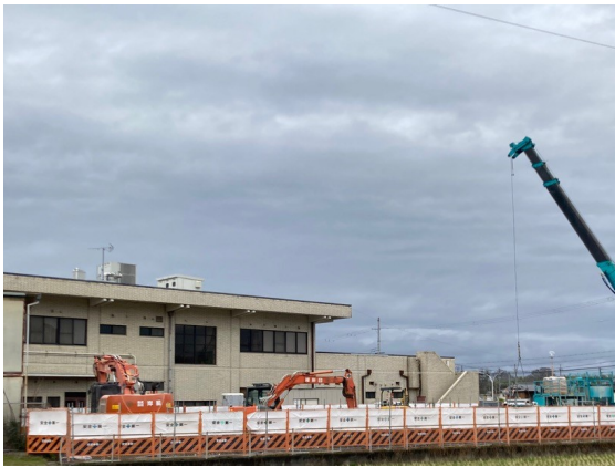
基礎杭除去(R8. 3. 3～)
