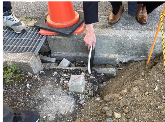
解体工事後現場検査(R8. 3. 27)
