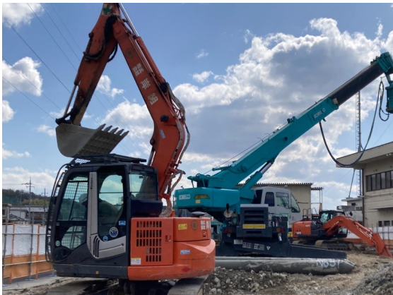
基礎杭除去(R8. 3. 10～)
