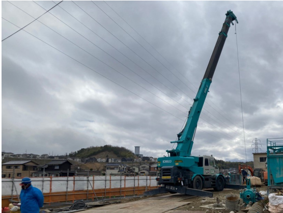
基礎杭除去機材の搬入(R8. 3. 3～)
