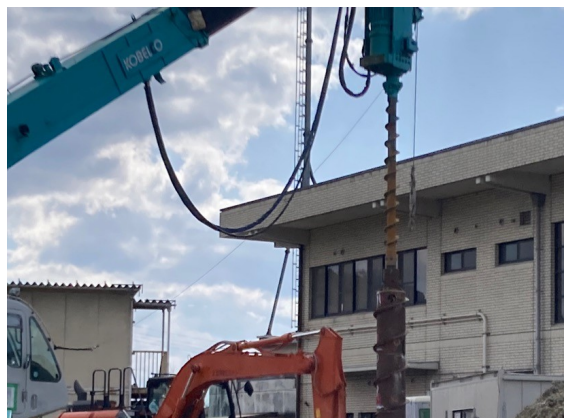
基礎杭除去(R8. 3. 10～)
