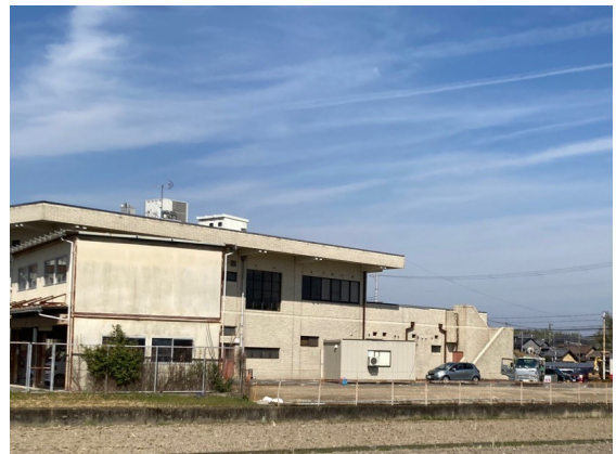
基礎杭除去後跡地(R8. 3. 24～)
