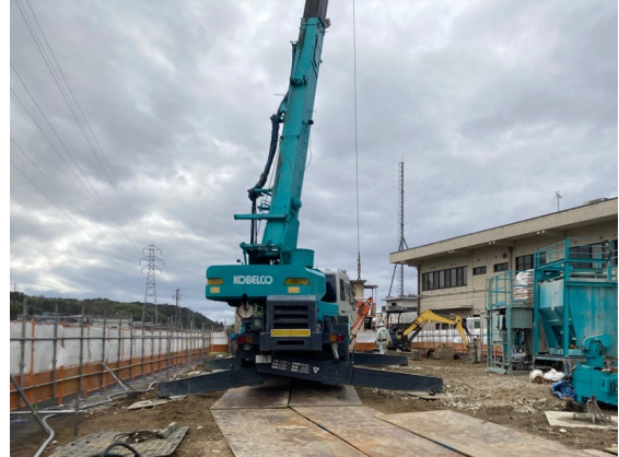
基礎杭除去機材の搬入(R8. 3. 3～)
