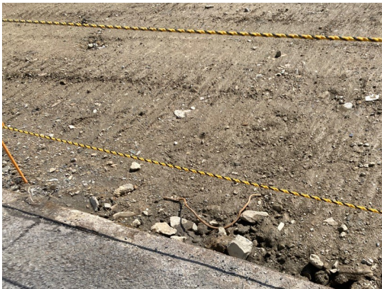
解体工事後現場検査(R8. 3. 27)
