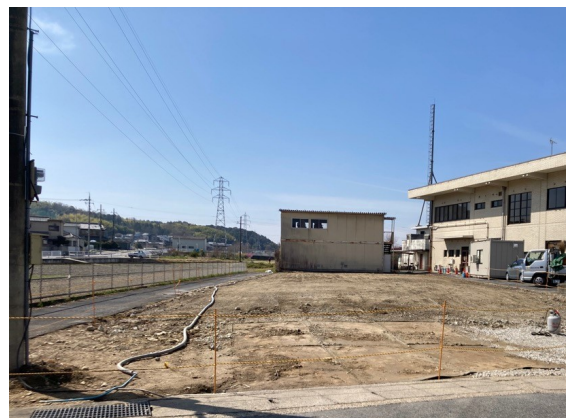
基礎杭除去後跡地(R8. 3. 24～)
