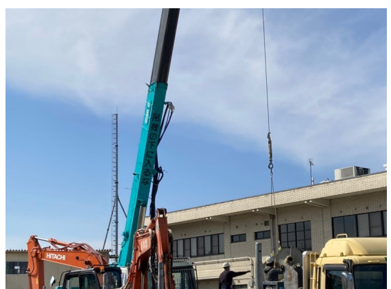
基礎杭除去(R8. 3. 17～)
