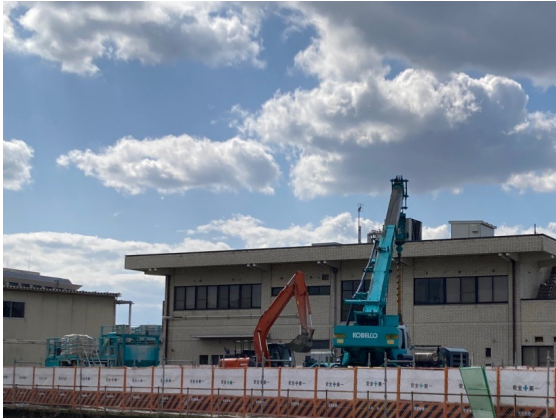
基礎杭除去(R8. 3. 10～)
