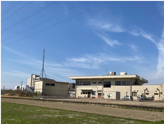
基礎杭除去後跡地(R8. 3. 24～)
