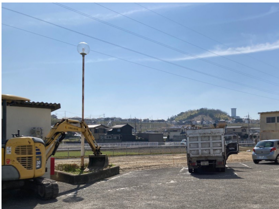
基礎杭除去後跡地(R8. 3. 24～)
