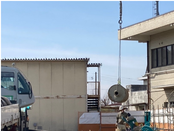
基礎杭除去(R8. 3. 17～)
