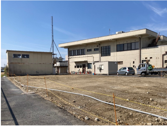
基礎杭除去後跡地(R8. 3. 24～)
