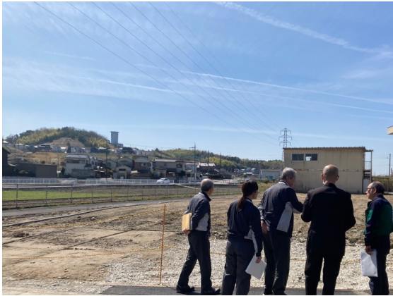
解体工事後現場検査(R8. 3. 27)
