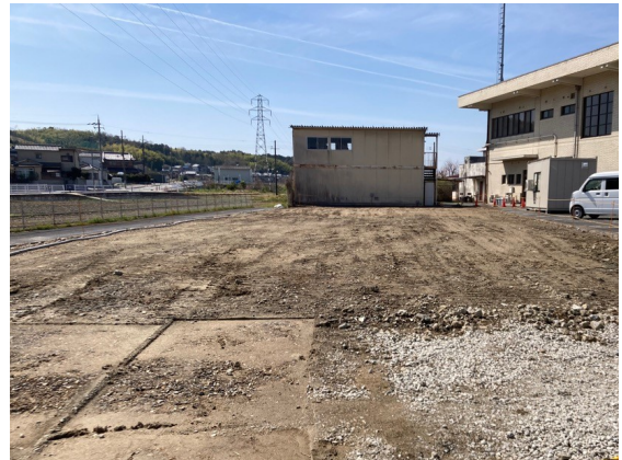
解体工事後現場検査(R8. 3. 27)
