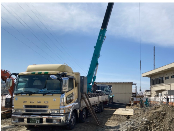
基礎杭除去(R8. 3. 17～)
