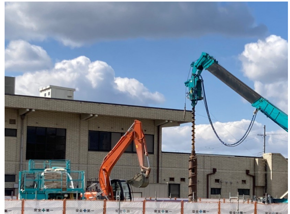
基礎杭除去(R8. 3. 10～)
