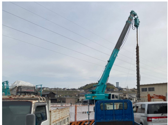
基礎杭除去(R8. 3. 3～)
