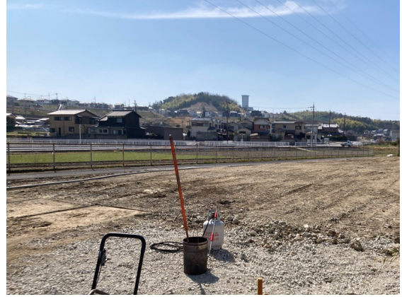
基礎杭除去後跡地(R8. 3. 24～)
