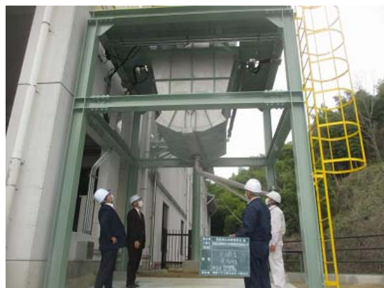
完成検査〔脱水汚泥ホッパ〕(R3. 3. 30)
