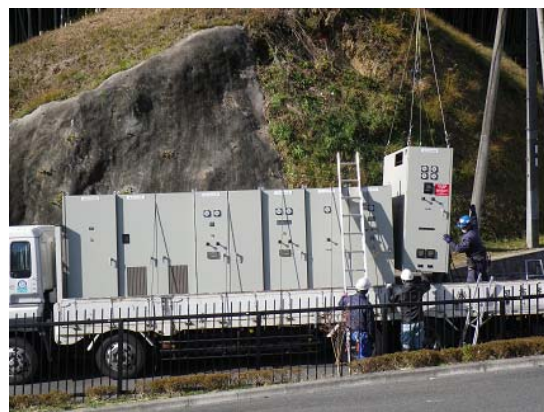
高圧受電盤更新(R2. 12. 28)
