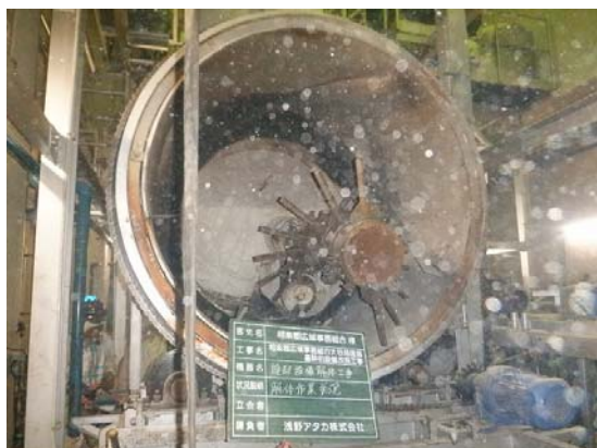
焼却設備解体(R2. 10. 1~)
