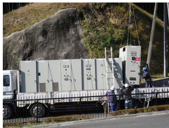
高圧受電盤更新(R2. 12. 28)
