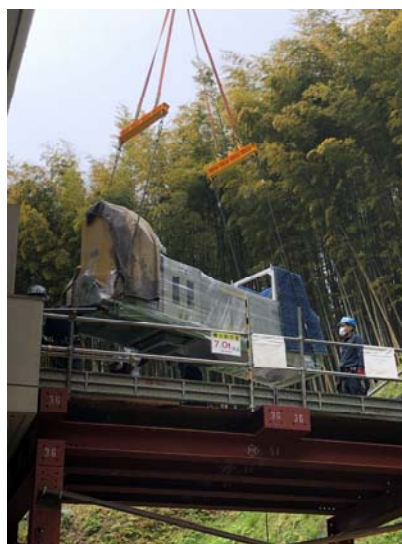
脱水設備更新(R2. 5. 4)
