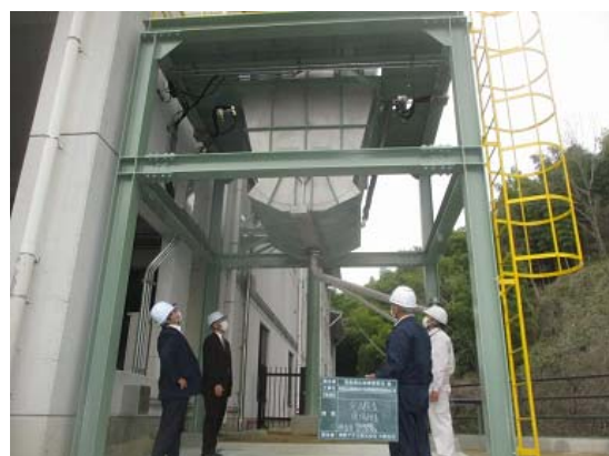
完成検査〔脱水汚泥ホッパ〕(R3. 3. 30)
