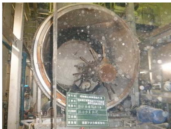
焼却設備解体(R2. 10. 1~)
