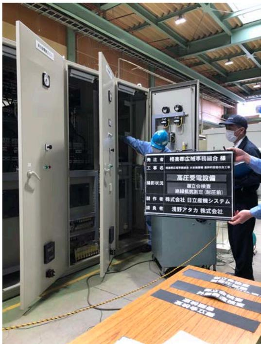
高圧受電盤工場検査①(R2. 3. 24)
