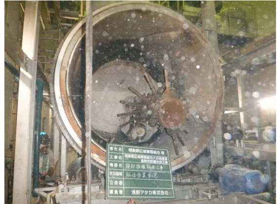
焼却設備解体②(R2. 10. 1～)
