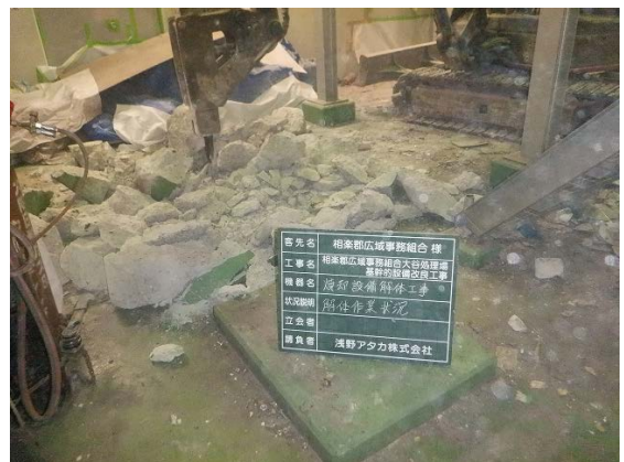
焼却設備解体④(R2. 10. 1～)
