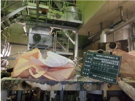
焼却設備解体①(R2. 10. 1～)
