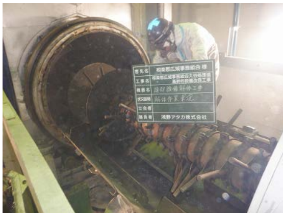
焼却設備解体③(R2. 10. 1～)
