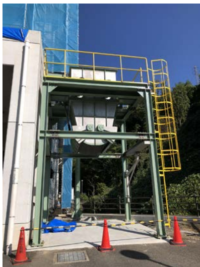
脱水汚泥ホッパー設置状況① (R2. 10. 17～)
