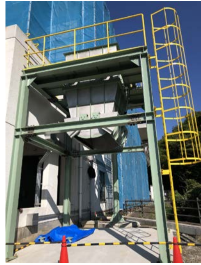
脱水汚泥ホッパー設置状況② (R2. 10. 17～)
