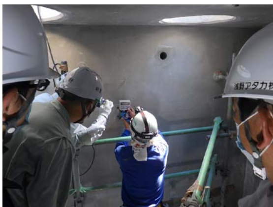
防食塗膜工事引張試験(R2. 8. 11)
