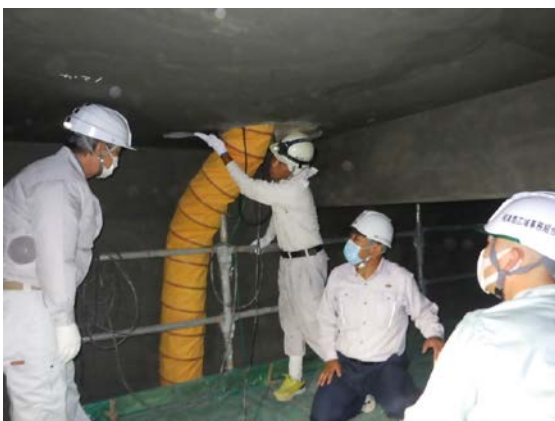
防食塗膜工事素地調整後確認検査 (R2. 8. 20)
