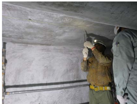
防食塗膜工事断面修復後確認検査 (R2. 8. 11)
