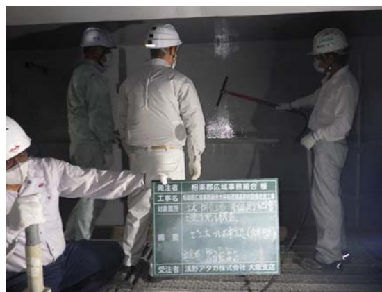
防食塗膜工事ピンホール試験 (R2. 8. 31)
