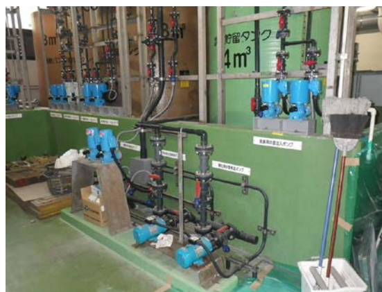
薬注ポンプ設置(R2. 8. 17)
