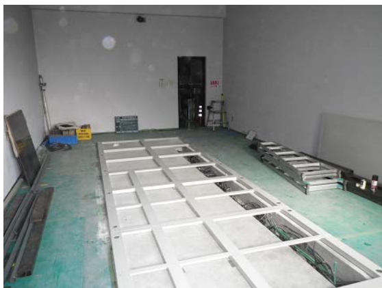
高圧受電盤納入前(R2. 12. 27)
