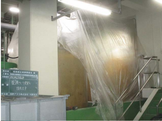
薬品タンク撤去①(R3. 1. 26)
