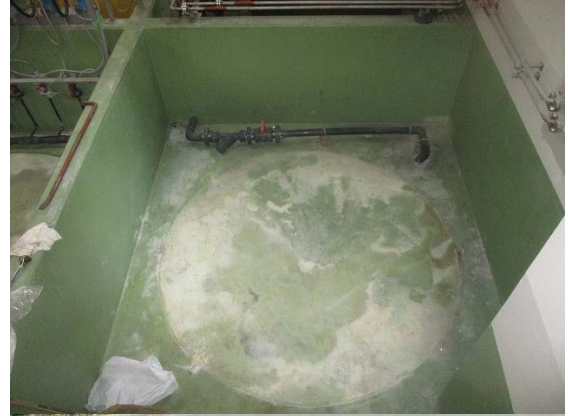
薬品タンク撤去②(R3. 1. 26)
