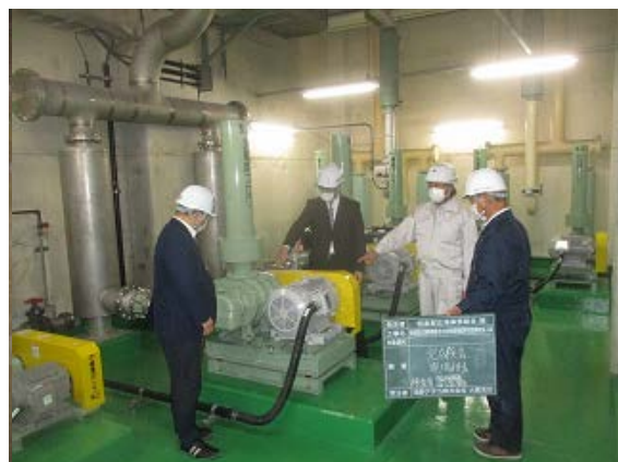
完成検査〔流動床ブロワ〕(R3. 3. 30)
