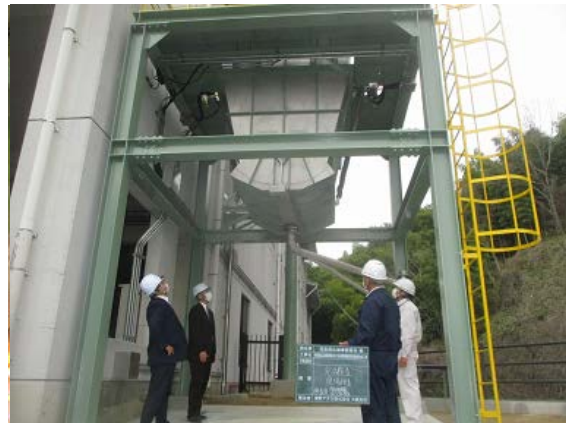
完成検査〔脱水汚泥ホツパ〕(R3. 3. 30)
