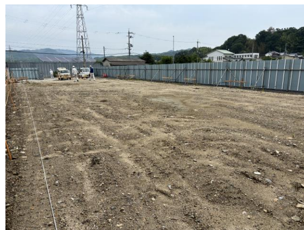
仮囲い完成(R8. 6. 30)
