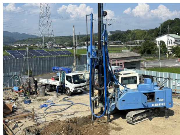
▶杭打工事(R8. 7. 21)
