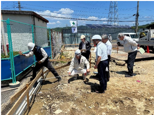
▶杭芯検査(R8. 7. 9)
