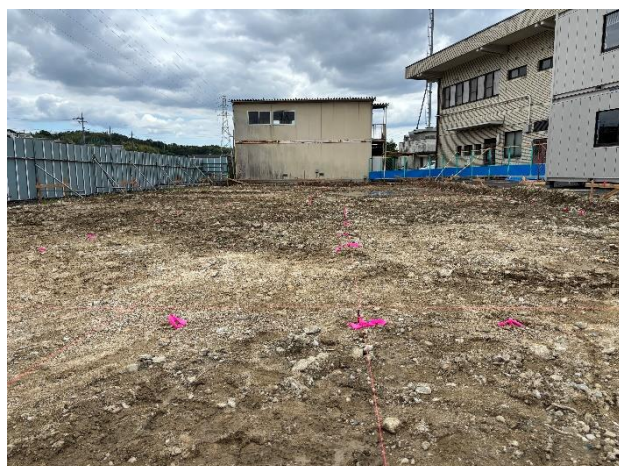
▶杭芯出し(R8. 7. 8)
