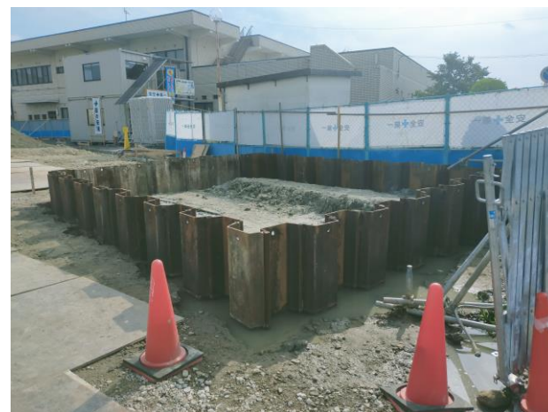
▶鋼矢板圧入工事(R8. 7. 30)
