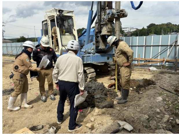
▶杭打検査(R8. 7. 13)
