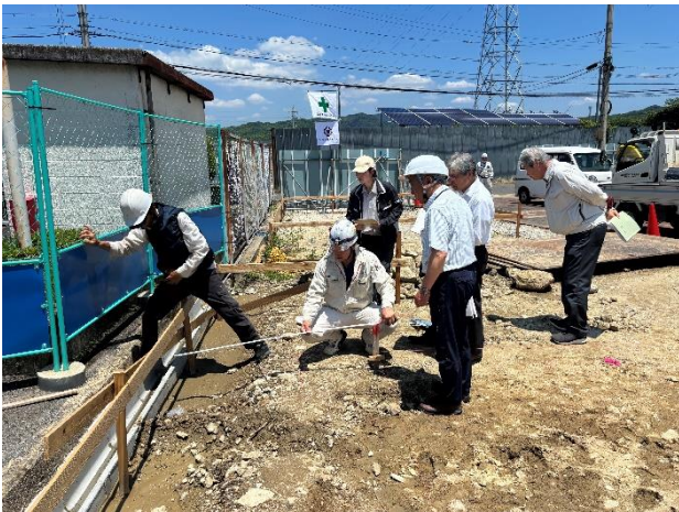
▶杭芯検査(R8. 7. 9)
