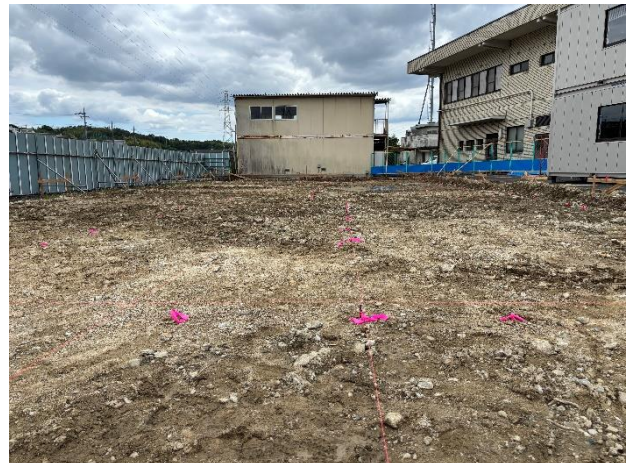
▶杭芯出し(R8. 7. 8)
