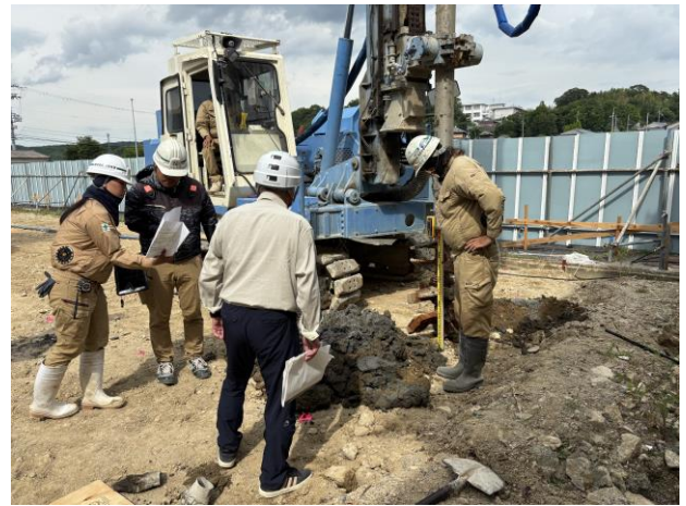
▶杭打検査(R8. 7. 13)
