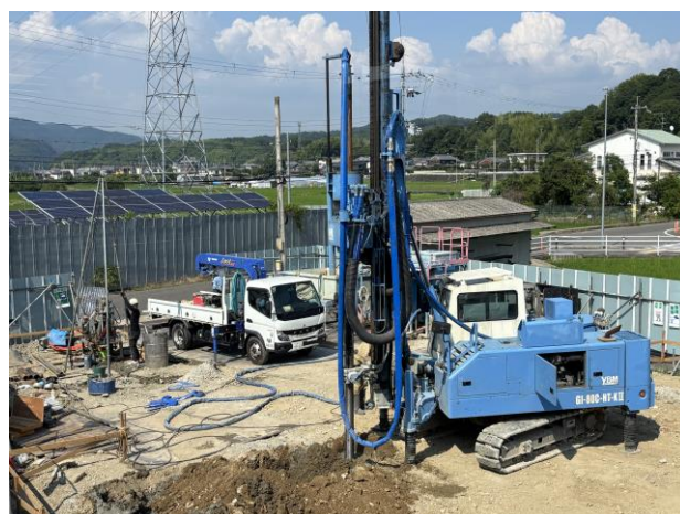
▶杭打工事(R8. 7. 21)
