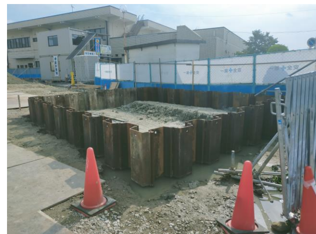
▶鋼矢板圧入工事(R8. 7. 30)
