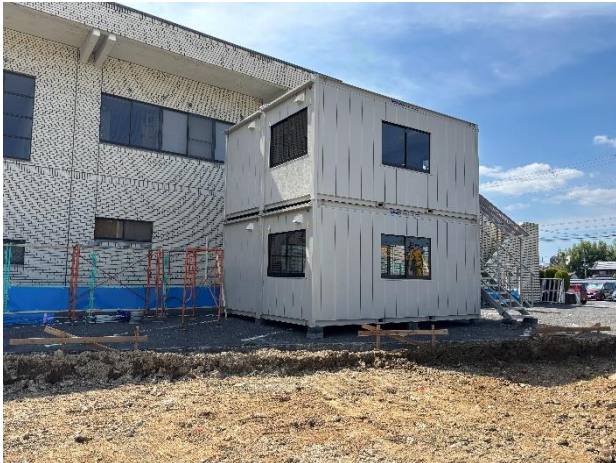
▶仮設事務所設置(R8. 7. 3)
