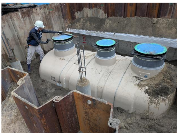
▶浄化槽設置工事①(R8. 8. 27)
