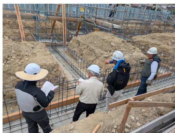
▶配筋検査(R8. 8. 27)
