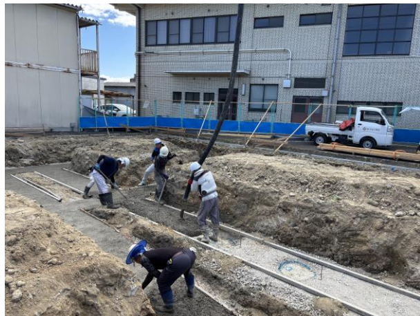
▶コンクリート打設工事①(R8. 8. 7)
