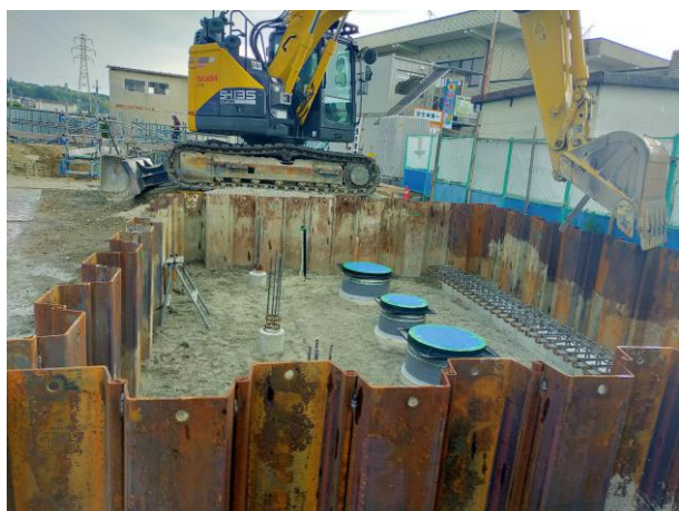
▶浄化槽設置工事②(R8. 8. 31)
