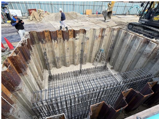
▶浄化槽鉄筋組(R8. 8. 7)
