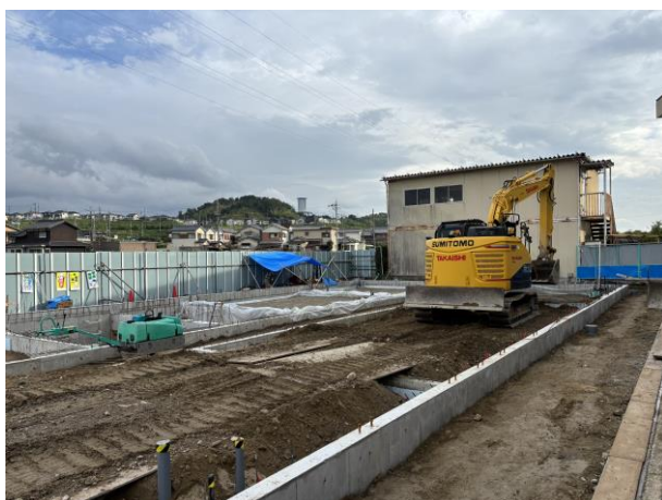
▶設備配管工事(R8. 9. 28)
